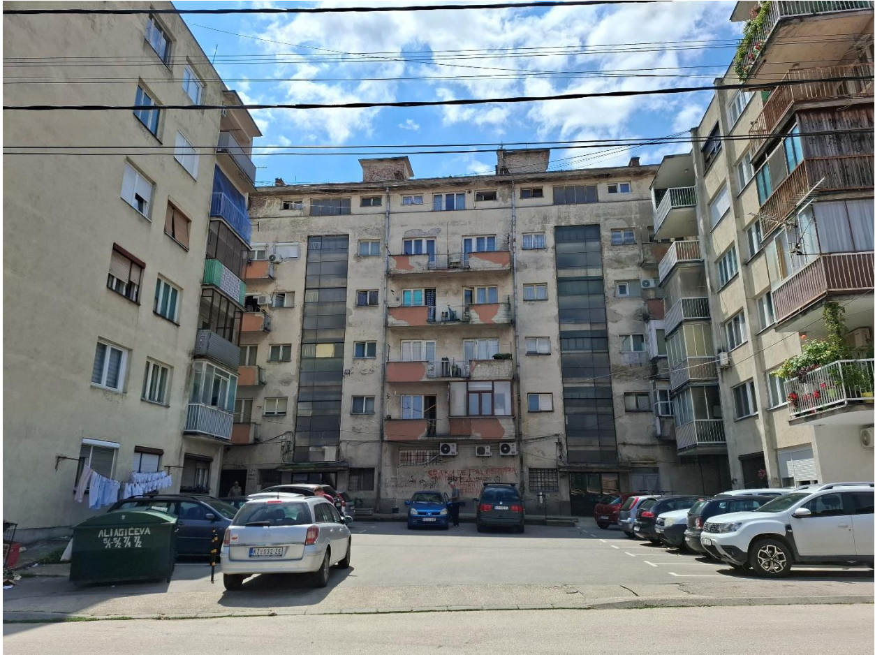
Слика 3.1. Поглед на предметну локацију ка југоистоку
